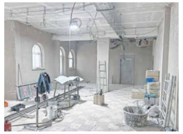
Im Inneren laufen die Arbeiten an Elektrik, Lüftung, Heizung und Sanitär auf Hochtouren. Viele Wände sind verputzt, die Brandschutzdecken drin. Fotos: Stadt Freital
